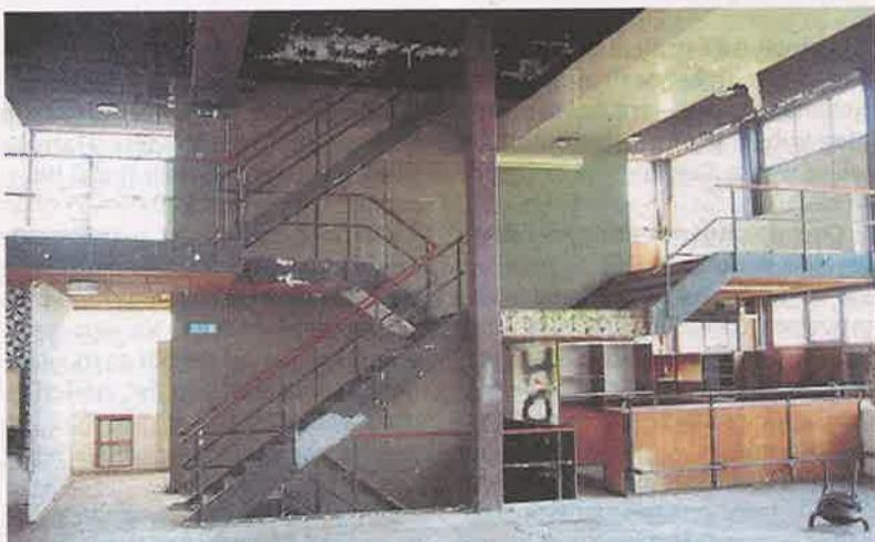
Het interieur van het hoofgebouw voor de renovatie. FOTO BOEI
