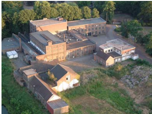
Het Gietelinck - Portierscomplex
