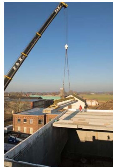
De 16 meter lange betonplaten worden op de inbouwbox van de theaterzaal gehesen
