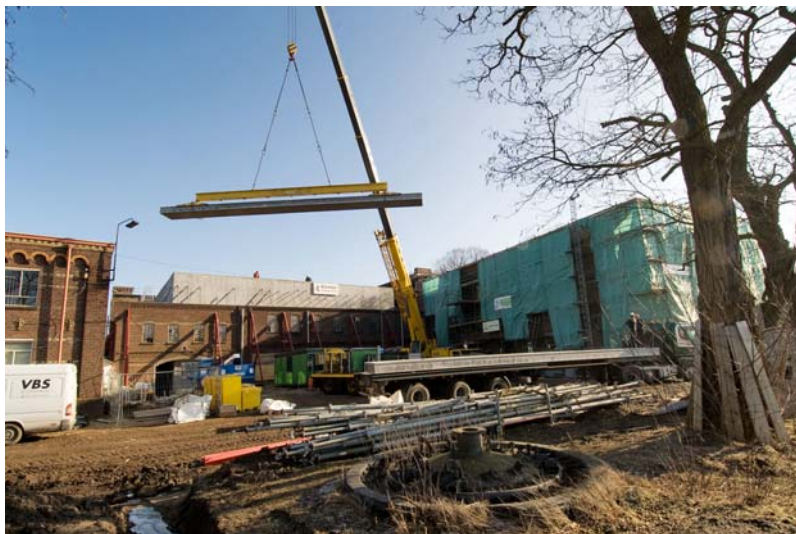
De 16 meter lange betonplaten worden op de inbouwbox van de theaterzaal gehesen
